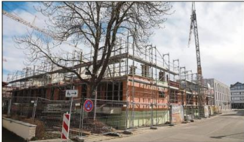
Eine neue Wohnanlage mit 26 barrierefreien Appartements entsteht am Attinger Weg und ermöglicht betreutes Wohnen. Foto: Hans Kronseder
